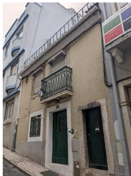
F18. Rua da Caridade nº 18-20 (à esq)
